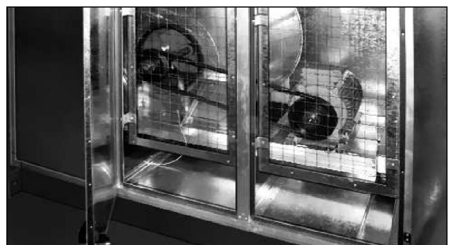
Передача защищена сеткой
