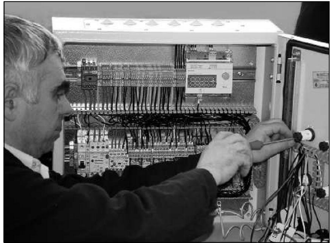
Автоматика собственной сборки
